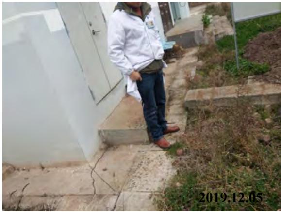
院内雨水收集沟渠
