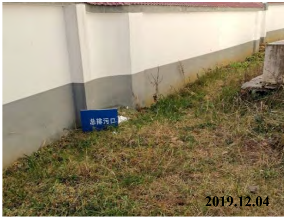
污水总排放口
