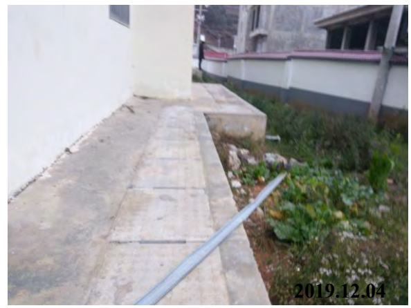
院内雨水收集沟渠
