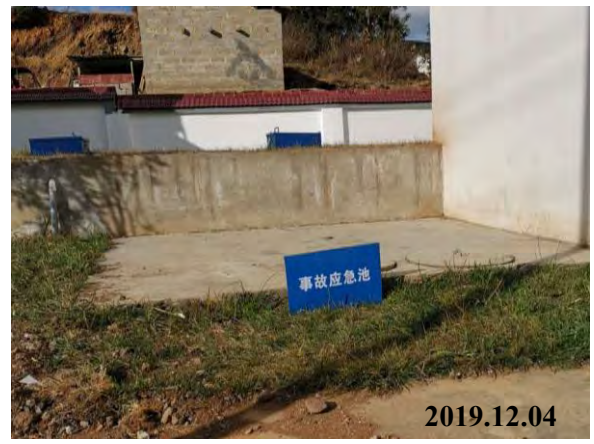
污水处理站事故应急池
